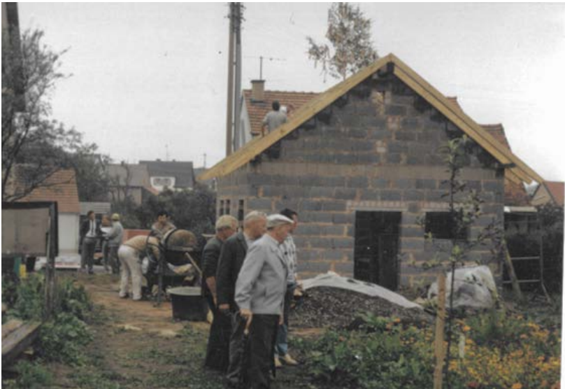
Abbildung 8: Bau des Kelterhauses
